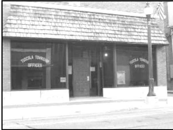
TUSCOLA TOWNSHIP OFFICE 104 N. Main St.
